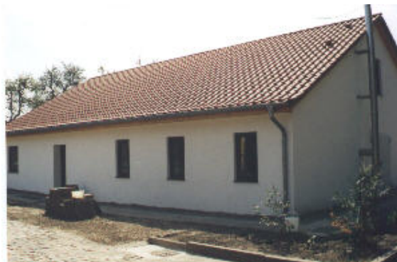
Die Rückfront (West) mit Lagereingang und Abzug der Ölheizung
